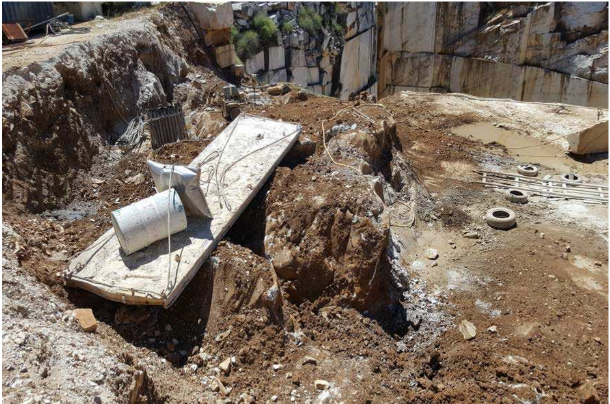
Figura 5 - solo existente na zona de ampliação da corta P1
